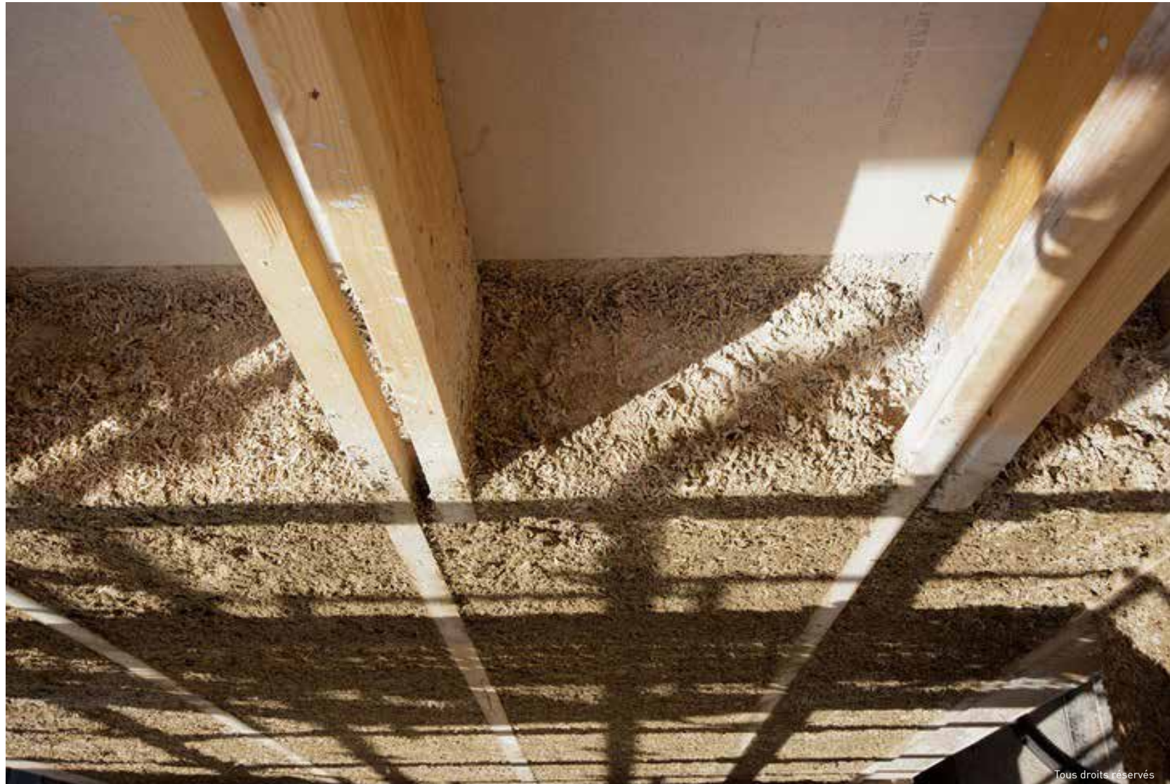
BÉTON DE CHANVRE ET STRUCTURE BOIS APPARENTE
